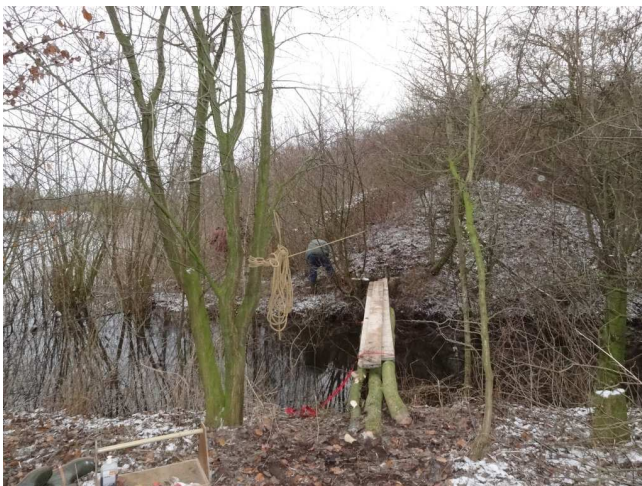
De 5 meter lange brug met railing is klaar.
